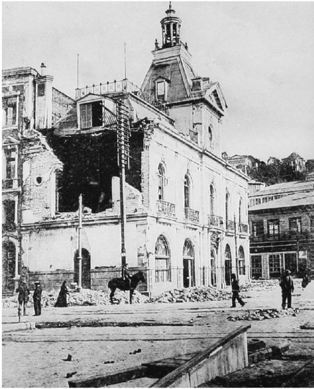
El centenar de hombres del Cuerpo de Bomberos de Santiago que viajó a Valparaíso debió cumplir diversas tareas de apoyo a los voluntarios porteños, cuyo Cuartel General, como se aprecia en la foto, resultó con severos daños estructurales.
