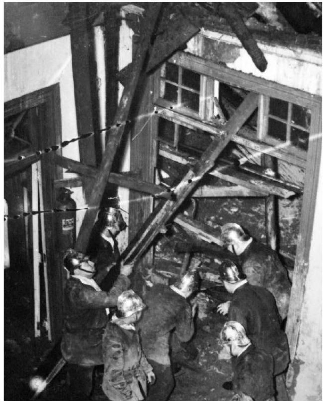
El lugar donde Máximo Humbser fue sorprendido por el derrumbe. Los voluntarios inician rápidamente el trabajo para recuperar el cuerpo de su comandante en la antigua construcción de Serrano 79.
