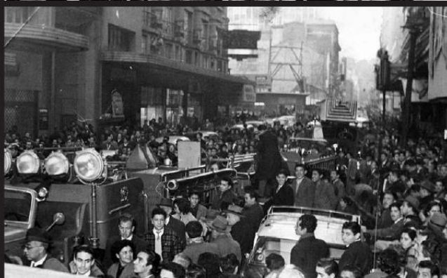
Arriba, las escalas telescópicas extendidas para el trabajo de incendio en altura. Abajo, el carro de especialidades de la Sexta Compañía, conocido como "el químico", rodeado por curiosos en un amago en pleno centro de la ciudad.
