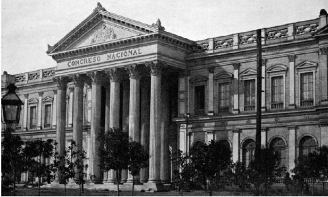
Arriba, histórica foto tomada a los bomberos y vecinos de la época en la mañana del 5 de junio de 1891, luego de haber controlado el gran siniestro de calle Atumada, que se recuerda como el incendio de la Unión Central, por haberse iniciado en ese lugar. Abajo, el hermoso edificio neoclásico del Congreso Nacional había sido construido junto a los jardines que recordaban la tragedia del templo de la Compañía de Jesús. El 18 de mayo de 1895, las llamas estremecían el mismo lugar.
