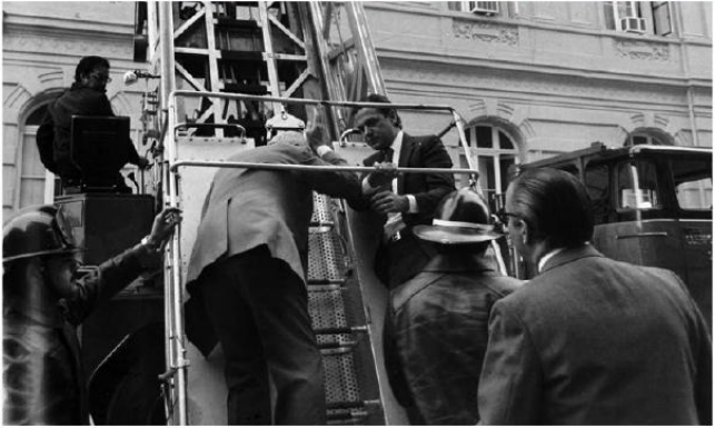
Arriba, apenas seis minutos después del violento terremoto de 1985 se dio la primera alarma de incendio en los laboratorios del colegio alemán Deutsche Schule. Abajo, apoyado por bomberos el entonces alcalde de Santiago, Carlos Bombal, realiza una inspección de los daños provocados por el sismo en diversos edificios patrimoniales del centro de la capital.
