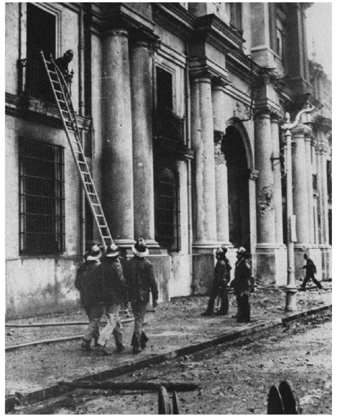
El trabajo de los voluntarios se prolongó durante todo ese 11 de septiembre, debiendo concurrir a tareas de remoción de escombros los días siguientes.
