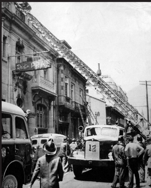
La mecánica de la Duodécima Compañía en un incendio que afecta un edificio ubicado al costado de los estudios de radio Pirat. El material mayor es Mercedes Benz y el personal lleva cotanas de cuero y el casco MSA, en servicio a partir de 1962.
