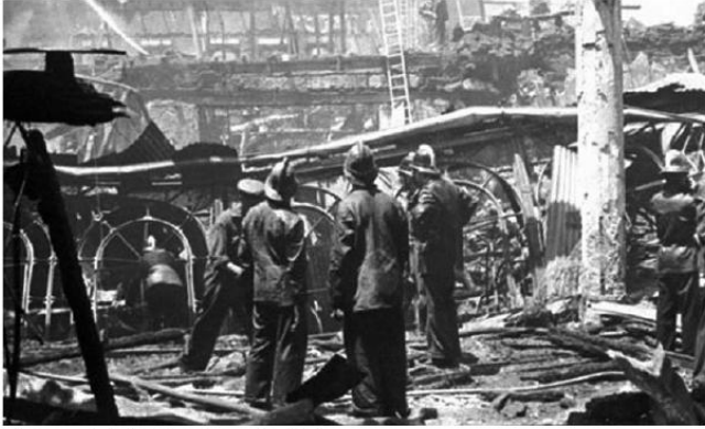
Imágenes correspondientes a la mayor tragedia humana que ha sufrido el Cuerpo de Bomberos de Santiago. Arriba, se observan los castillos de madera en los que se concentraba la acción de los voluntarios cuando se derrumbó el muro. Abajo, los compañeros de los caídos observan perplejos el lugar del accidente.
