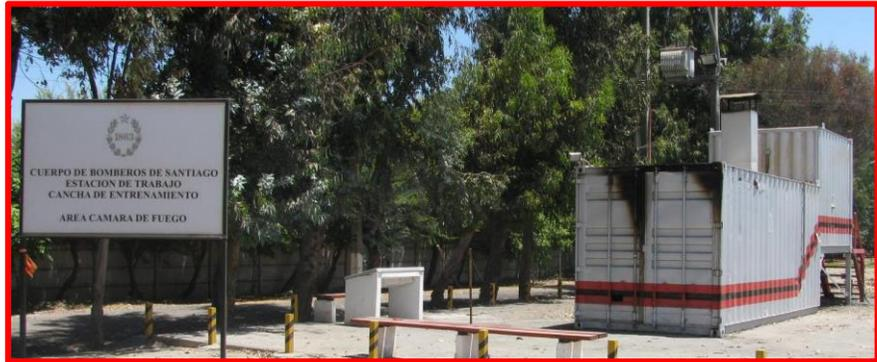
El simulador denominado Cámara de Fuego o de Flashover del Campo de Entrenamiento Comandante Máximo Humbser Zumarán ocupa una superficie de 198 m<sup>2</sup>., siendo su estructura muy parecida a un container, dotado en su interior de una alta tecnología que permite medir, evaluar el comportamiento del fuego y otorgar la máxima seguridad a los Bomberos que ingresan a ella.
